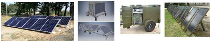
Rys. 3. Widok zaimplementowanych na poligonie WITI zestawów modułów fotowoltaicznych, mobilne bloki fotowoltaiczne i mobilny system polowej elektrowni fotowoltaicznej
