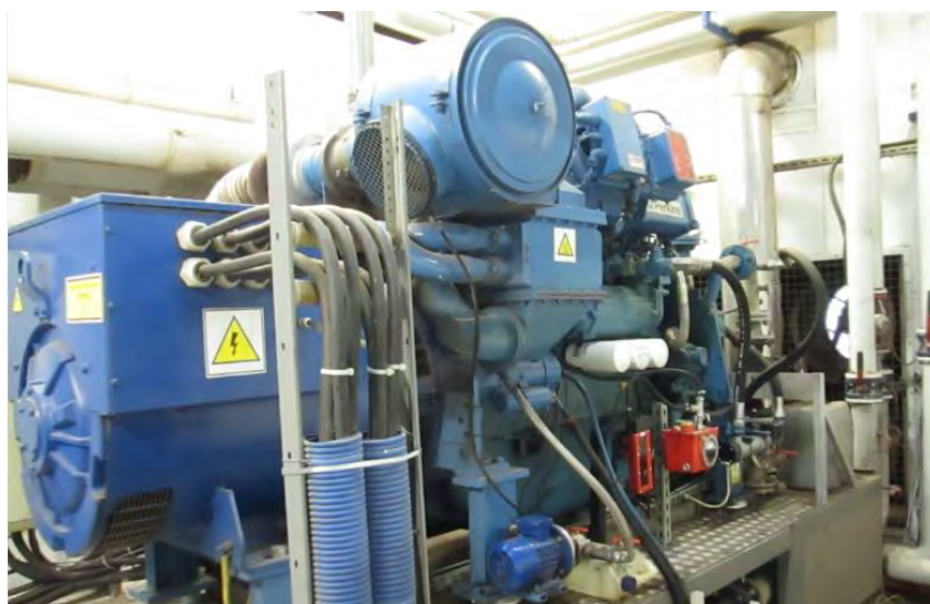
Rys. 2. Zespół kogeneracyjny (SSp + PE) zasilanego biogazem [źródło własne]
